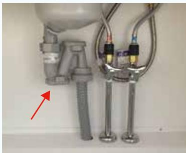
②水漏れ部分のジョイントナットに緩みがないか確認して下さい。緩みがある場合は、時計回りに締め直します。
